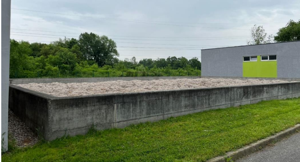
Slika 19. Biofilter pogona za preradu materijala kategorije 1 i 2 – kokosova vlakna (foto: Josipa Lovasić)
