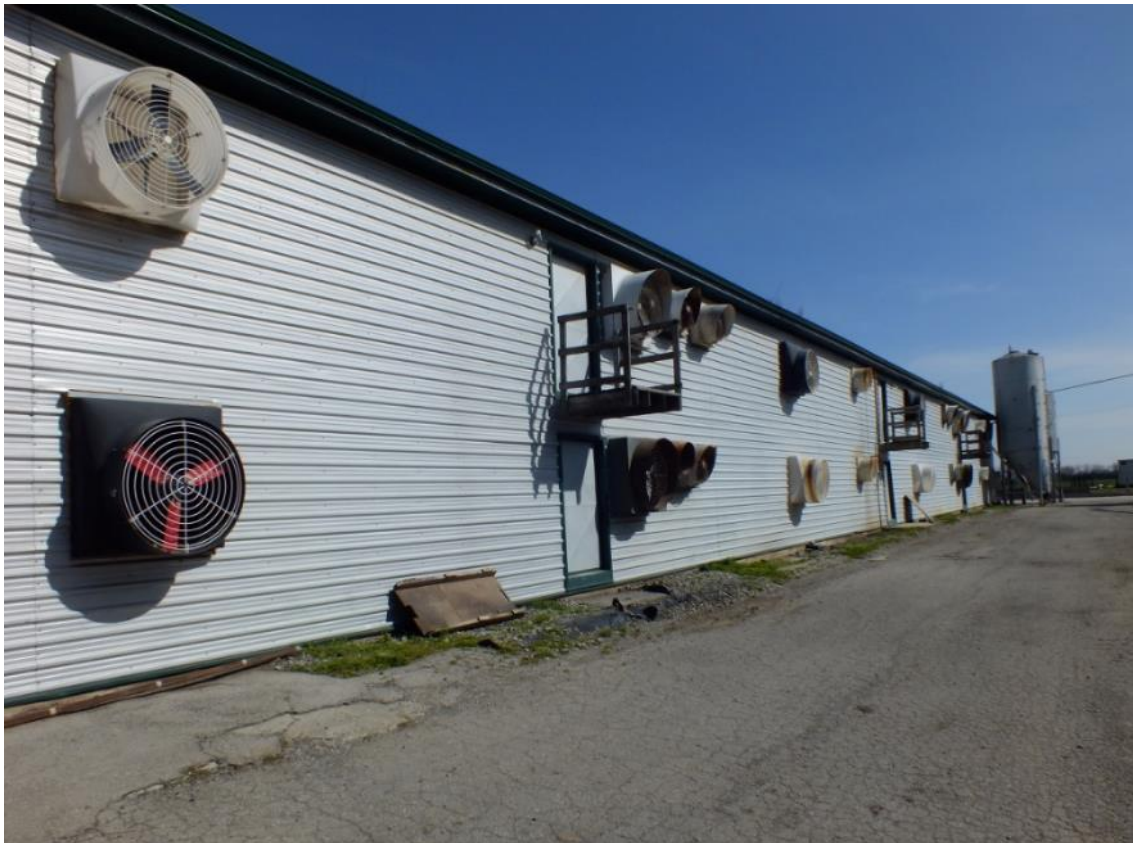
Slika 7. Horizontalni sustav ventilacije
