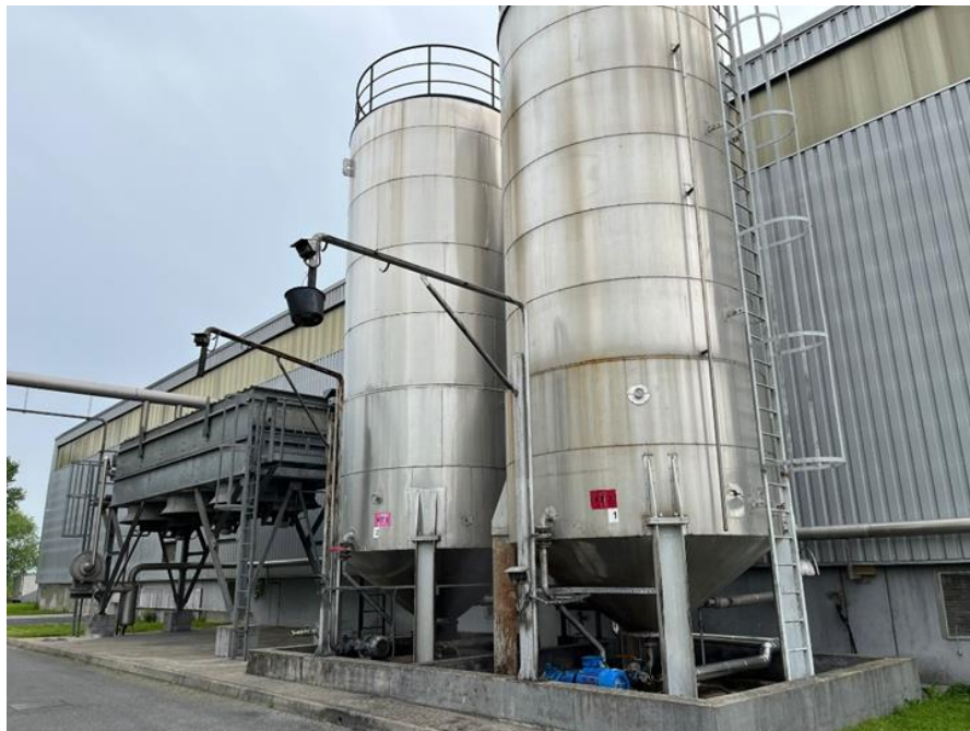
Slika 24. Spremnici za skladištenje masti pogona za preradu materijala kategorije 1 i 2 (foto: Josipa Lovasić)
