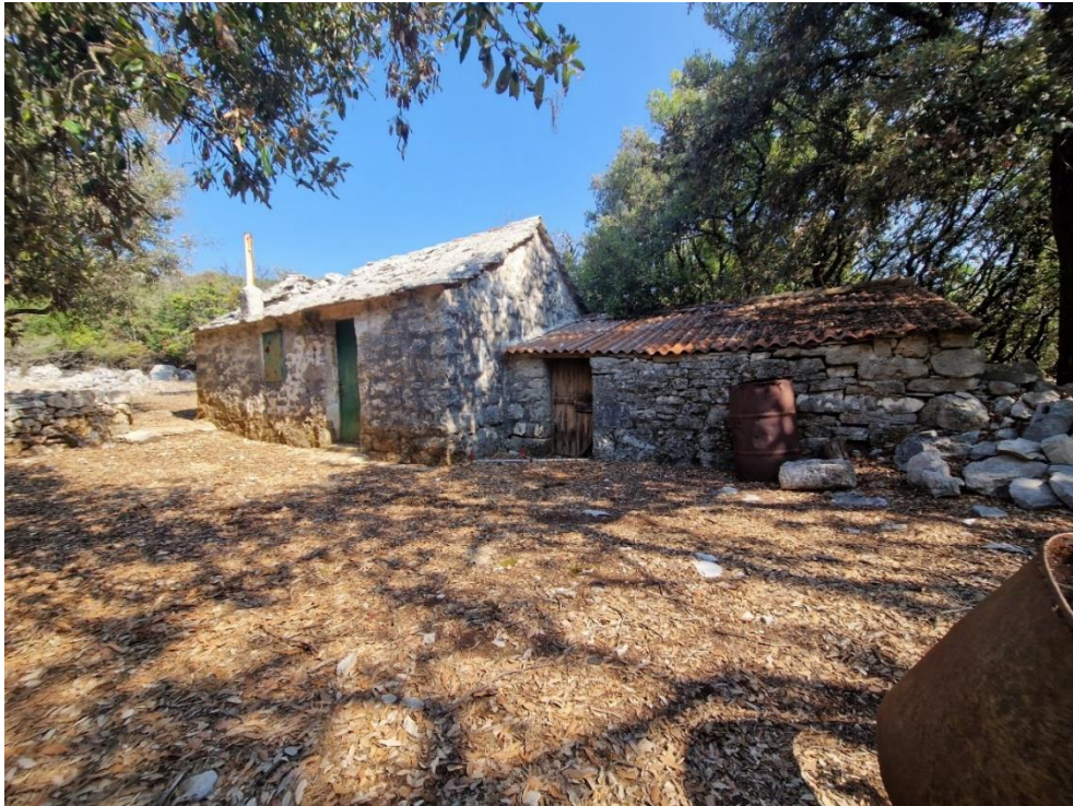
Slika 11. Potleušice na Dubovim vratima u blizini Pražnica, desna manja je starije građe, dok je lijeva naknadno izgrađena, fotografirala Jasna Kusanović
