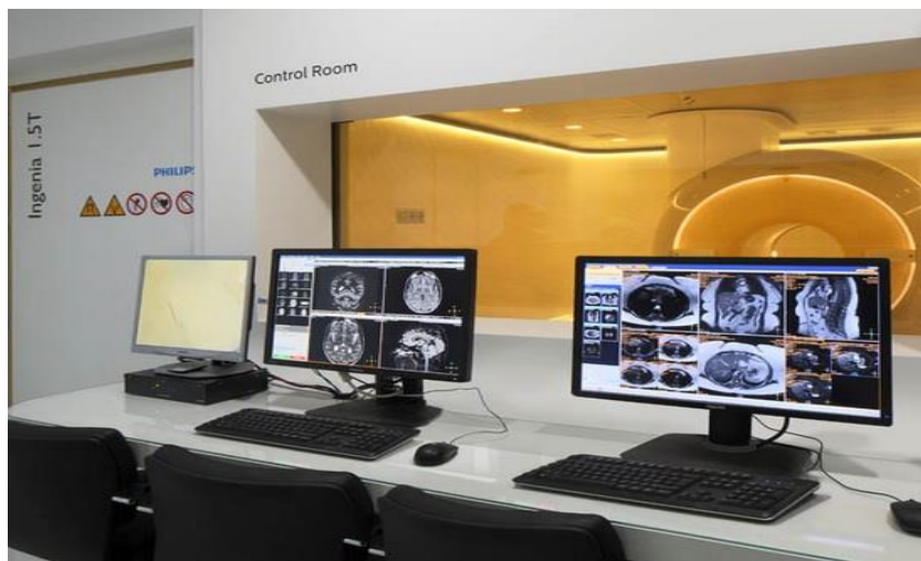
Slika 89. Kontrolna soba s računalnim sustavom
