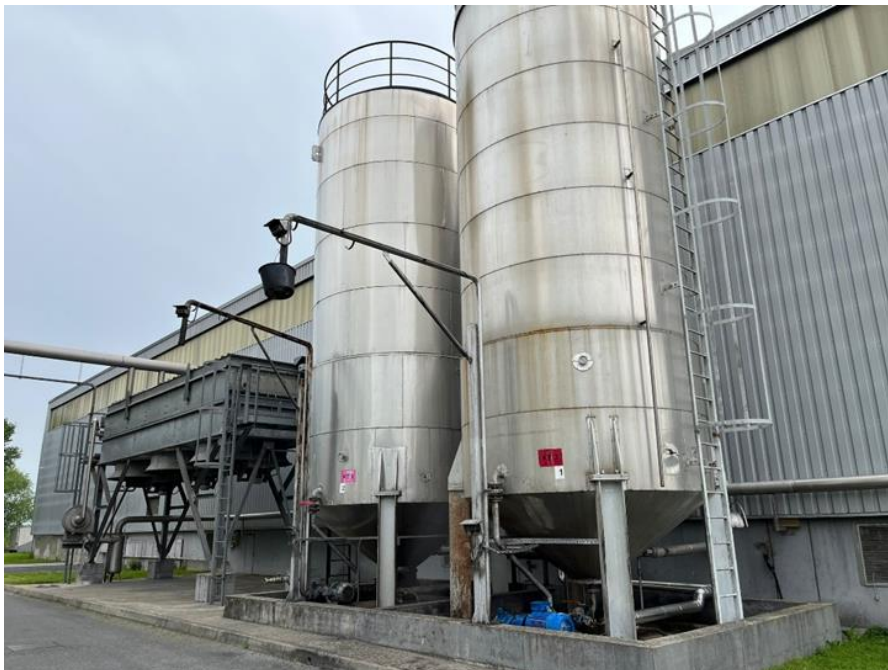
Slika 24. Spremnici za skladištenje masti pogona za preradu materijala kategorije 1 i 2 (foto: Josipa Lovasić)
