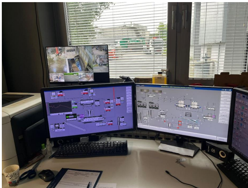
Slika 30. Kontrolni sustav pogona za preradu materijala kategorije 1 i 2 (foto: Josipa Lovasić)
