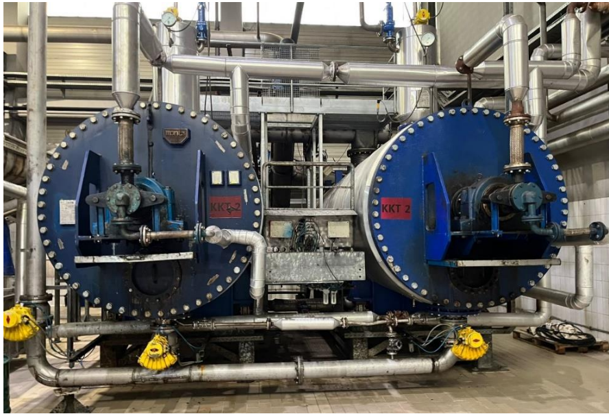
Slika 16. Sterilizatori materijala kategorije 1 i 2 (foto: Josipa Lovasić)
