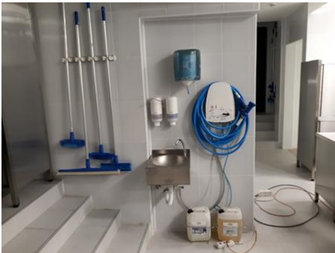
Slika 8. Centralna crpka s pripadajućim dijelovima.
