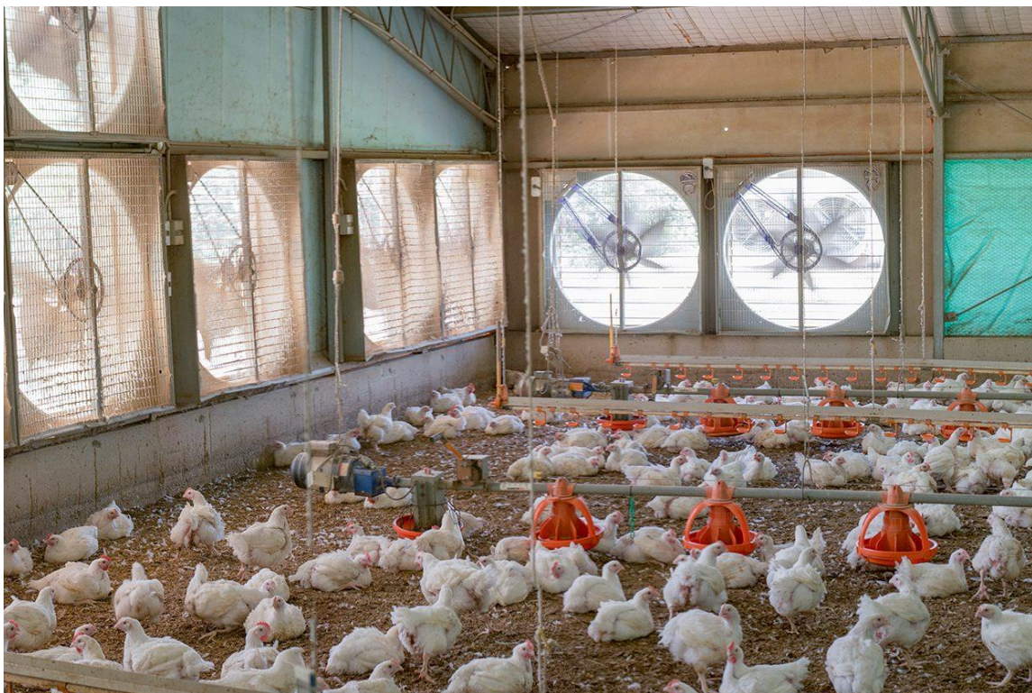
Slika 8. Kombinirani vertikalni i horizontalni sustav prozračivanja
